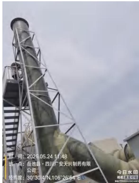
危废暂存间密闭设置，废气通过管道收集后至单独设置的1套“碱洗+水洗+活性炭吸附”废气处理设施处理后通过1根15m排气筒（DA004）排放
