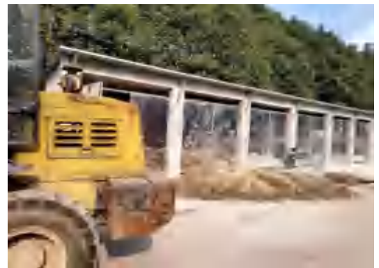
大英县鑫九州再生资源回收利用有限责任公司 项目危废暂存间
