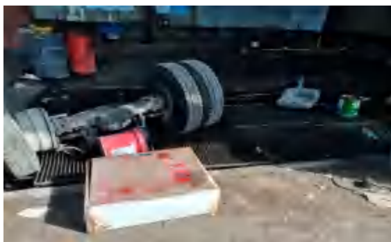
大英县鑫九州再生资源回收利用有限责任公司 项目发电机拆解现场
