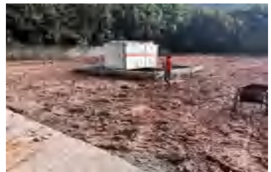
四川义奥涂料有限公司生产 废水处理站现状
